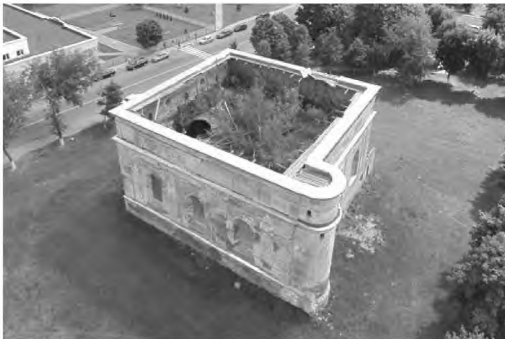
Рисунок 3 — Быховская синагога. На внутренней стороне аттика видны заложённые кирпичом бойницы XVII в.
